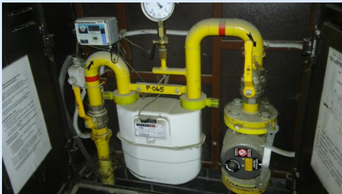
ZAWÓR ODCINAJĄCY GAZU STEROWANY ZDALNIE (tzw. ZAWÓR MAG)
