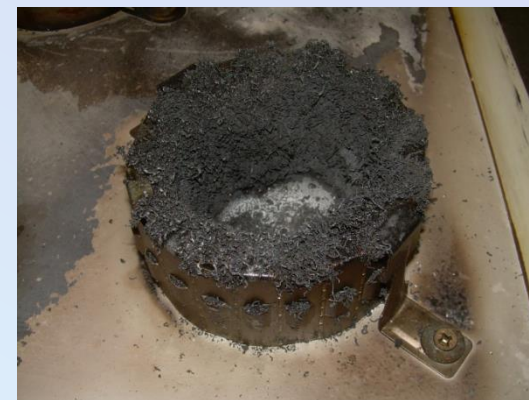
PRZEJŚCIE NIEPALNE (RURY INSTALACJI WODNEJ Z TWORZYWA SZTUCZNEGO)
