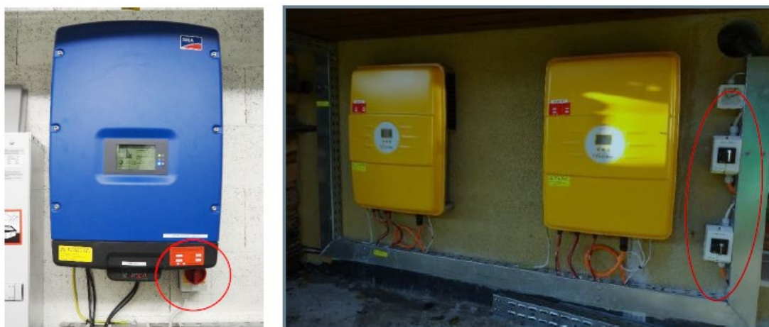
Ryc. 10. Przykłady lokalizacji rozłączników prądu AC za falownikiem
