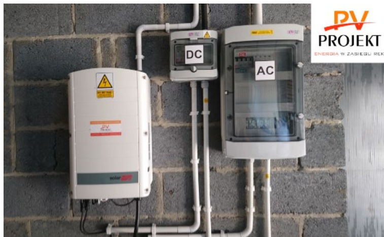
Ryc. 13. Przykład przyłącza falownika
